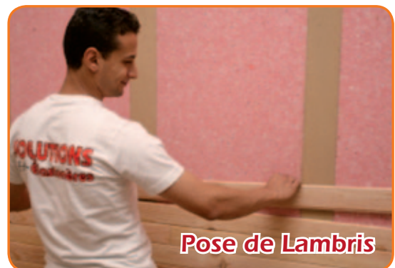
La Pose de lambris est également très facile sur les montants du Kit acoustique
