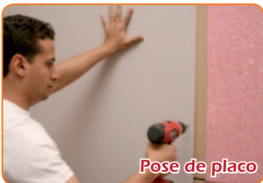
Fixer les plaques de Placo sur les montants
