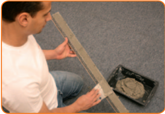
Encoller la face mousse des montants à l'aide de la spatule crantée
