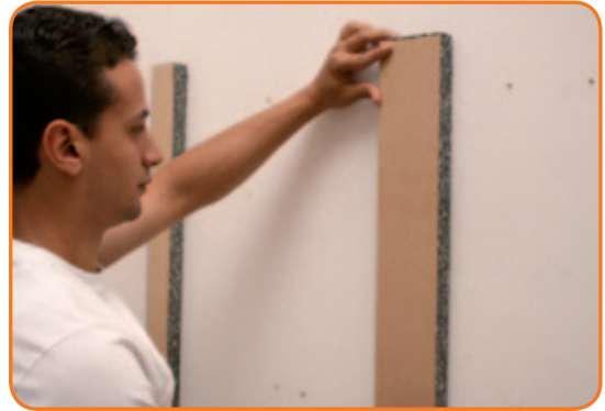
Plaquer les montants sur le mur
